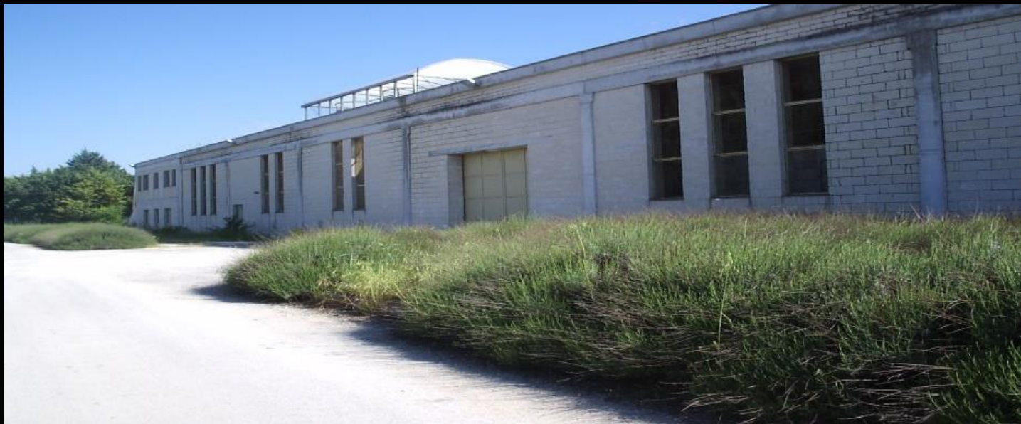
Impianto di post trattamento in località Pantano mai andato in funzione
