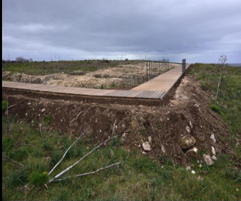
Villaggio Neolitico di Murgia Timone - realizzazione massicciata percorsi turistici
