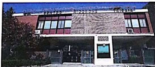
CENTRO RICERCHE TRISAIA L'ingresso situato a ridosso della strada statale 106
